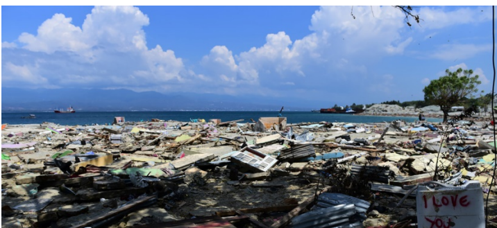
津波で倒壊した建物 ドンガラ県 Loli Pesua 村 2018.10.3 (UNICEF)
